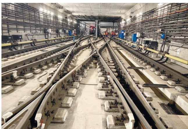
Перекрестный съезд типа Р65 марки 2/9 с междупутьем 5,3 метра
